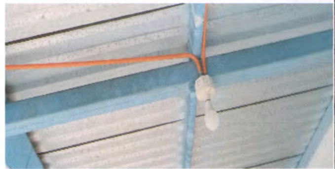
Foto 4: inicio de colocación de ducto en pasillo del establecimiento para la Reparación de sistema eléctrico
