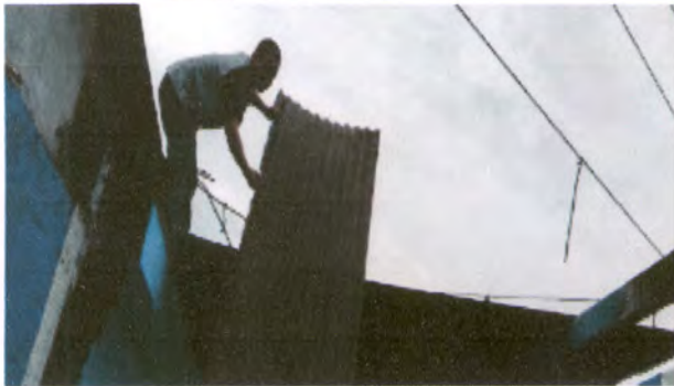
Foto1: Sustitución de lámina, por lámina troquelada aluzinc calibre 26, sustitución de estructura de soporte de metal por metal, se realiza la desinstalación de la estructura portante y lamina existente en mal estado,
