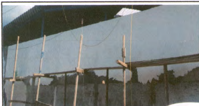
Foto 9: trabajo avanzado del Cernido en muro perimetral parte de enfrente del establecimiento.
