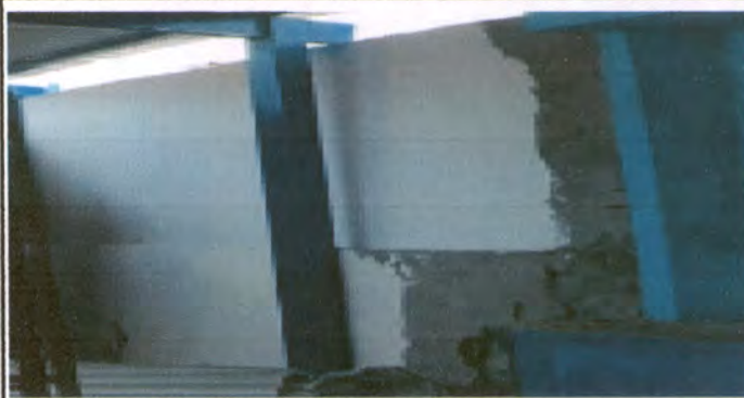
Foto 8: avance en el Repello y alisado en muro del perímetro del establecimiento
